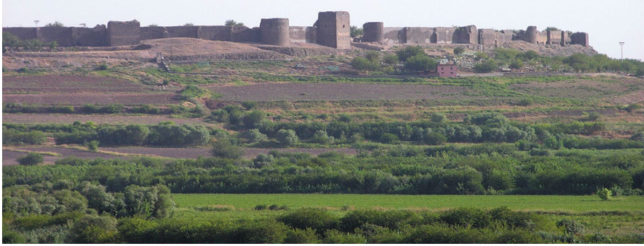
Görsel 3. Diyarbakır surları ve Dicle nehri ile sulanan tarım alanları
