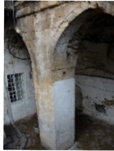
Şekil 16: A. Rahim Bakay evi avlu ve revak görünümü (Karabulut, 2019)
