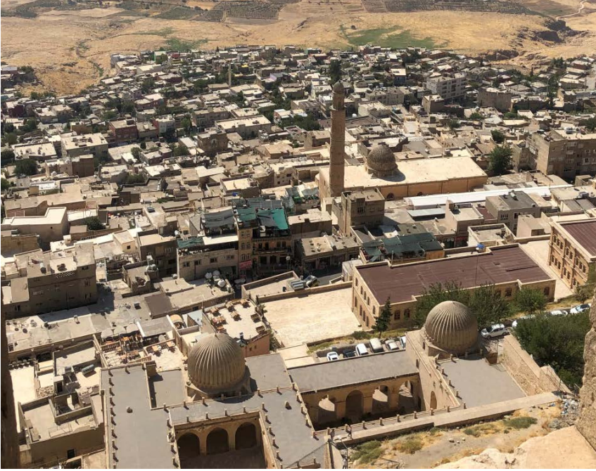
Şekil 10. Mardin Ulu Camii ve Zinciriye Medresesi Örtü Sistemi
