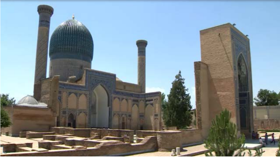
Şekil 5. Gur-i Emir Türbesi (TRT AVAZ, t.y)
